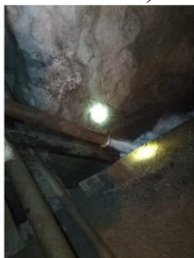
Рисунок 3.10 – Места установки испытательного оборудования, а – приемная труба скважины №2, б – приемные трубы скважин №1 (нижняя) и №3 (верхняя)
