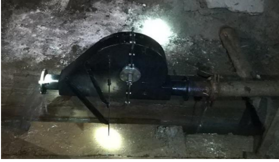
Рисунок 3.11 – Смонтированная в шахтных условиях на трубопровод скважины №2 гидротурбина, установленная в горизонтальном положении
